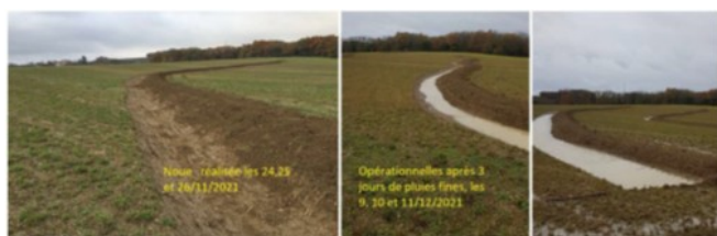
Figure 4 : Remplissage de la noue à différentes saisons, PermaVinéa, 2024
